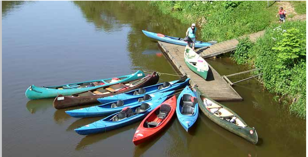
Beispiel für Bootsanleger mit Holzbelag
