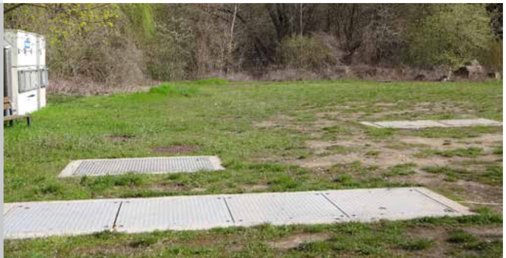
Bestand: Schächte des Regenrückhaltebeckens
