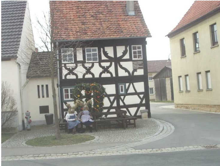
Sanierung Torhaus mit Jugendräumen
